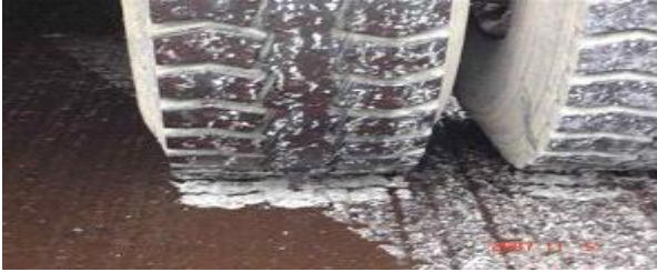
<그림 5> 덤프트럭에 의한 택코팅 손실
